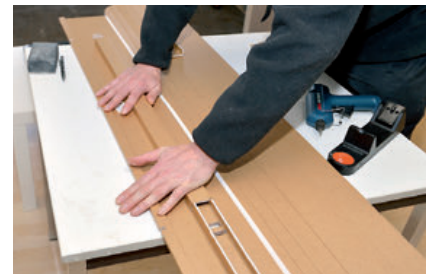
Nach dem Zusammenfügen müssen die Bauteile für ca. 45 Sekunden zusammengedrückt werden
