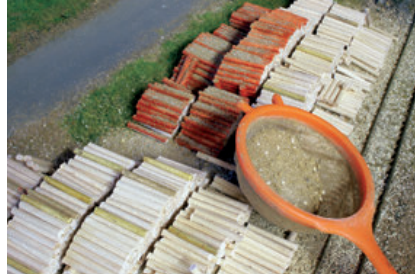
In die noch feuchte Farbe wird feinkörniges Erdreich mit einem Teesieb aufgestreut
