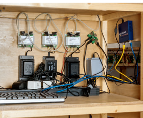
Die „Energiezentrale“ unter dem Hauptfahrpult. Beim Fototermin waren noch drei Booster von LDT installiert. Die Trafos kommen von Roco (3 x) und Märklin (1 x)
