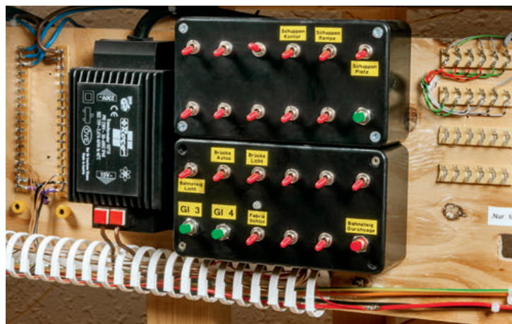
Die schwarzen Boxen sind zum Schalten für die Beleuchtung oder Sondereffekte in der Umgebung des Bahnhofs, es gibt Zugansagen und Hintergrundgeräusche
