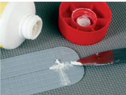
Die Nahtstellen zwischen den einzelnen Platten werden mit Spachtelmasse aus der Tube gefüllt
